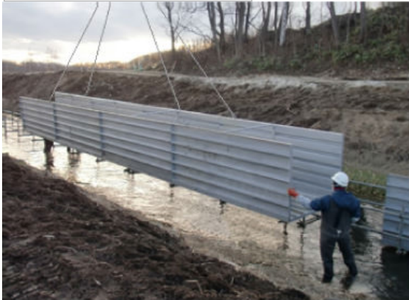
現場で水路を組立てる
